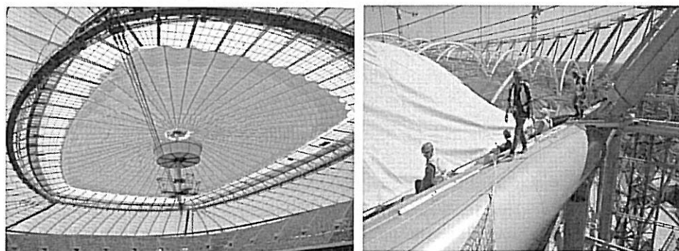
Rys. 9. Widok od wnętrza stadionu w kierunku iglicy (z lewej) oraz widok zewnętrznego pierścienia ściskającego (z prawej)
