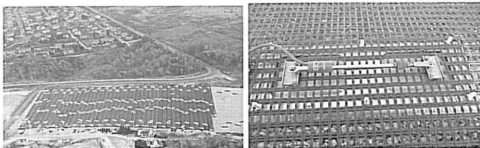
Rys. 16. Widok z lotu ptaka części systemu monitorowania odkształceń geosyntetyku oraz szczegół montażu ekstensometru strunowego
