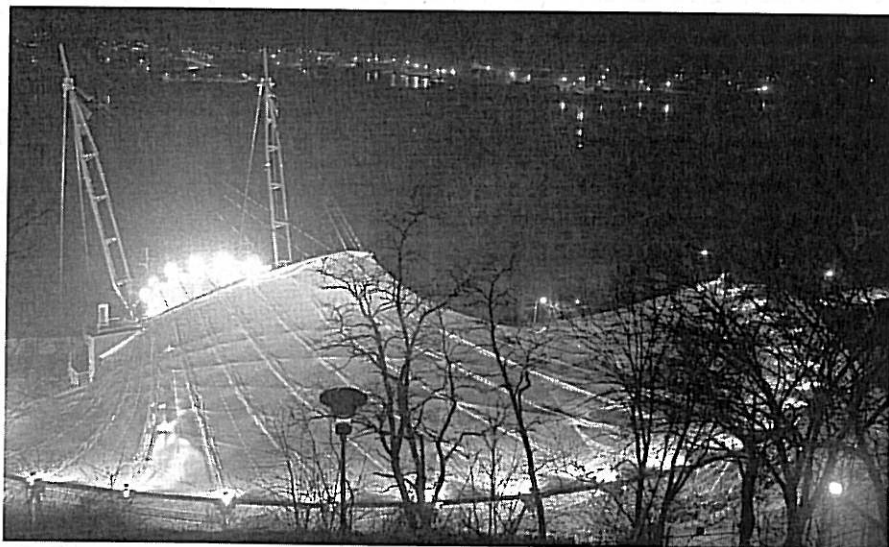
Rys. 10. Widok przekrycia Amfiteatru w Płocku
